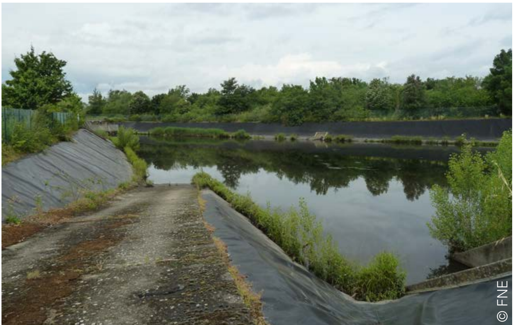
Bassin de rétention « un an »
