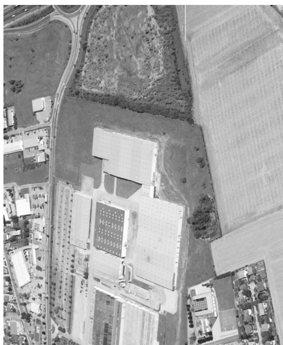
Etat du site avant l'opération
