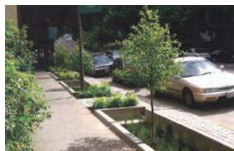
Ouvrage de rétention associé à la noue de l'allée.
