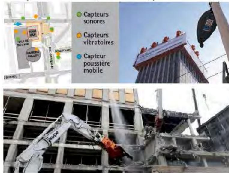
Figure 159 : Exemples de mesures mises en place dans le cadre du chantier de la Tour Incity : contrôle continu grâce à des capteurs (en haut), arrosage et micro-nébulisation pour limiter les poussières (en bas)
