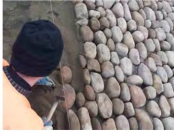
Les empièvements sont réalisés à partir des galets de Saône, récupérés sur le tracé de l'ancien chemin de halage.
