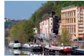
Zone de raccordement du pont sur le quai Gillet
