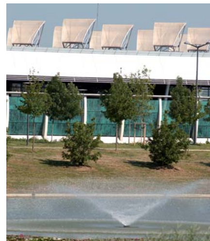
Centre de maintenance du tramway
