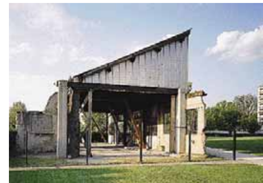
1994 – Hangar du 1 er film
