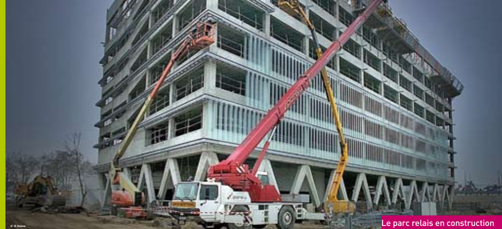
Le parc relais en construction
