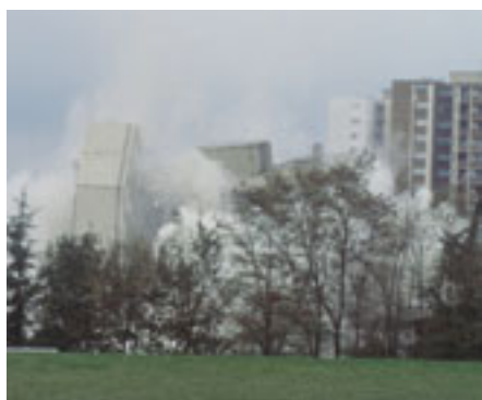
Démolition de la Tour 42 aux Minguettes Vénissieux
