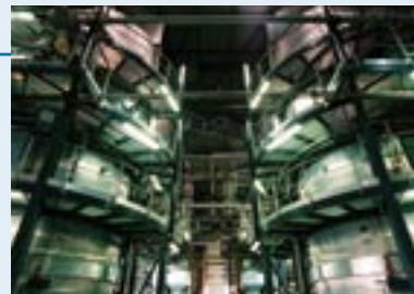
Fours d'incinération des boues
