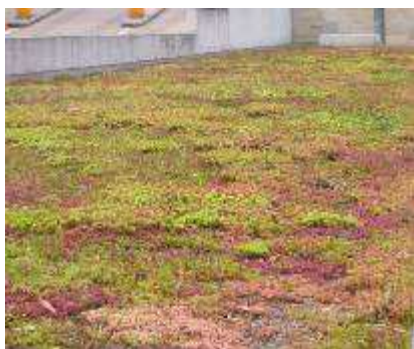
Fig.2 - Toiture parking parlement de Sarre – Allemagne
