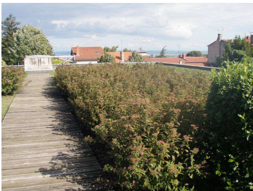
RÉSERVOIR DE STE FOY LES LYON - TOITURE JARDIN
