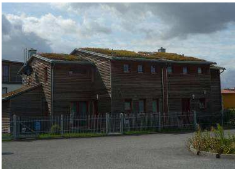
Fig.8a, b et c - Toiture maison jumelée – Ecolonia – Pays Bas, centre Solen et maisons privés à Berlin
