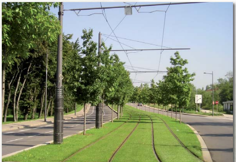
Voies de tramway
