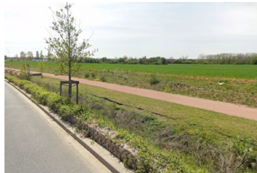
Exemple de terre-plein végétalisé large entre chaussée et aménagement cyclable, traité en noue.
