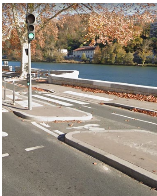
Exemple de « by-pass » cycliste entre une piste et un sas vélo en amont d'un feu
