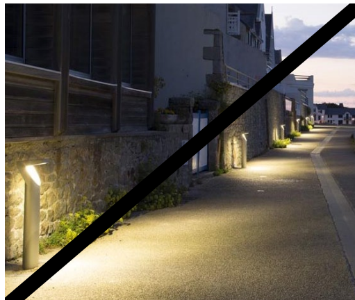
Les éclairage bas ne sont pas recommandés : trop rasants, ils ne permettent pas une visibilité claire de la piste sur toute sa largeur.
