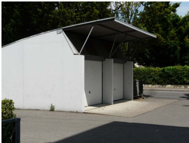
Box cité Saint-Jean sur la partie Sud de la rue des Jardins
