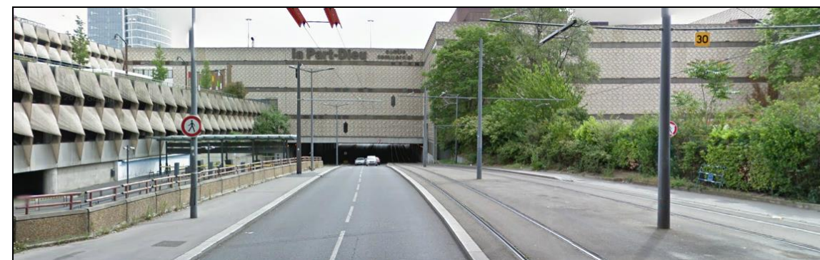
Figure 9 : Rue Servient, passage Est-Ouest sous le centre commercial interdit aux piétons
