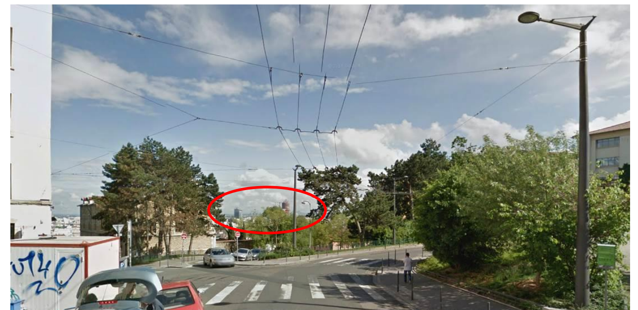
Figure 70 : Vue sur le site la rue d'Austerlitz sur le plateau de la Croix Rousse (source : Googlemaps, juin 2014)
