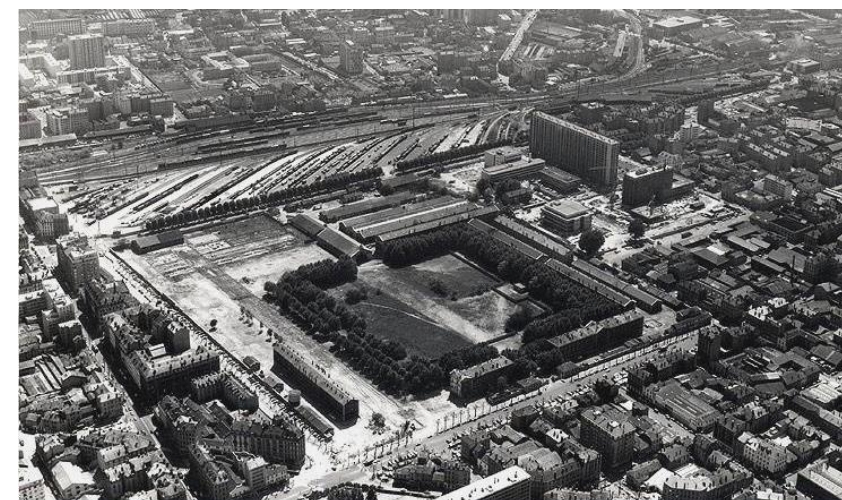
Figure 4 : Casernes de la Part-Dieu et emprise de la gare de marchandise au fond (cliché anonyme, source : archives municipales de Lyon, 1965)
