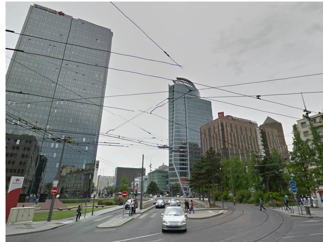
Figure 66 : Vue sur le site depuis le carrefour Vivier-Merle/Lafayette (source : Googlemaps, mai 2014)
