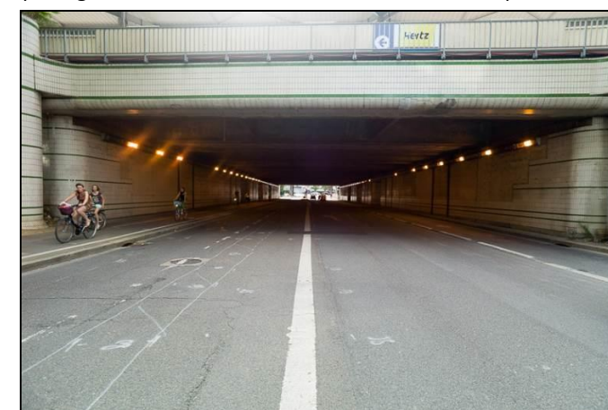
Figure 11 : Passage de l'avenue Pompidou sous les voies ferrées
