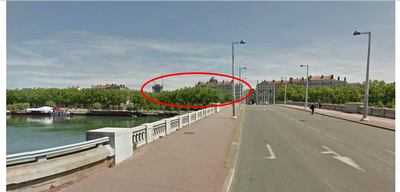
Figure 69 : Vue sur le site le Pont Wilson (source : Googlemaps, juin 2014)
