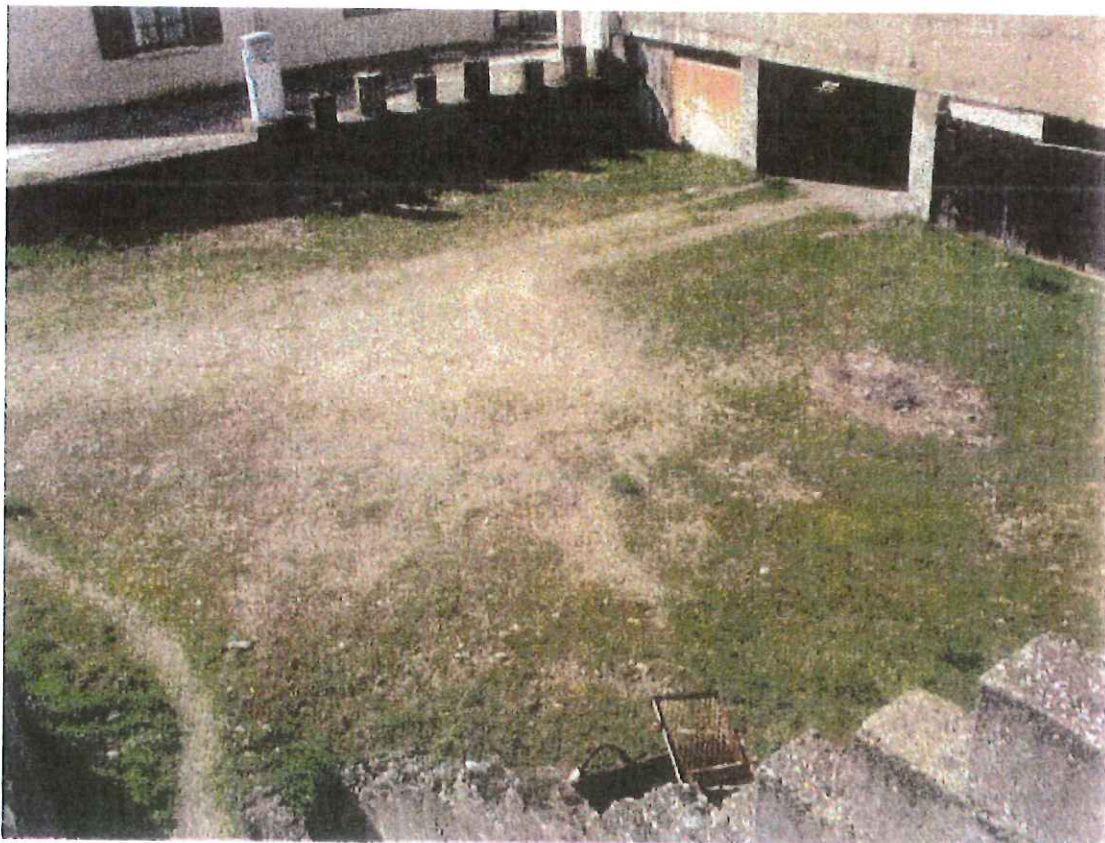
Emplacement du futur bassin d'infiltration/rétention de 390 m 3 du Nord-Est de la Z.A.C.
