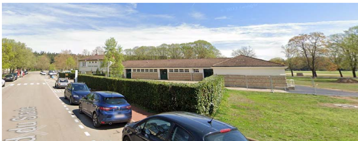
Figure 98: Photo du site depuis le boulevard du Stade, 2019
