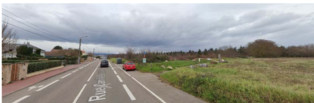
Figure 60 : Vue depuis la rue Camille Desmoulins
