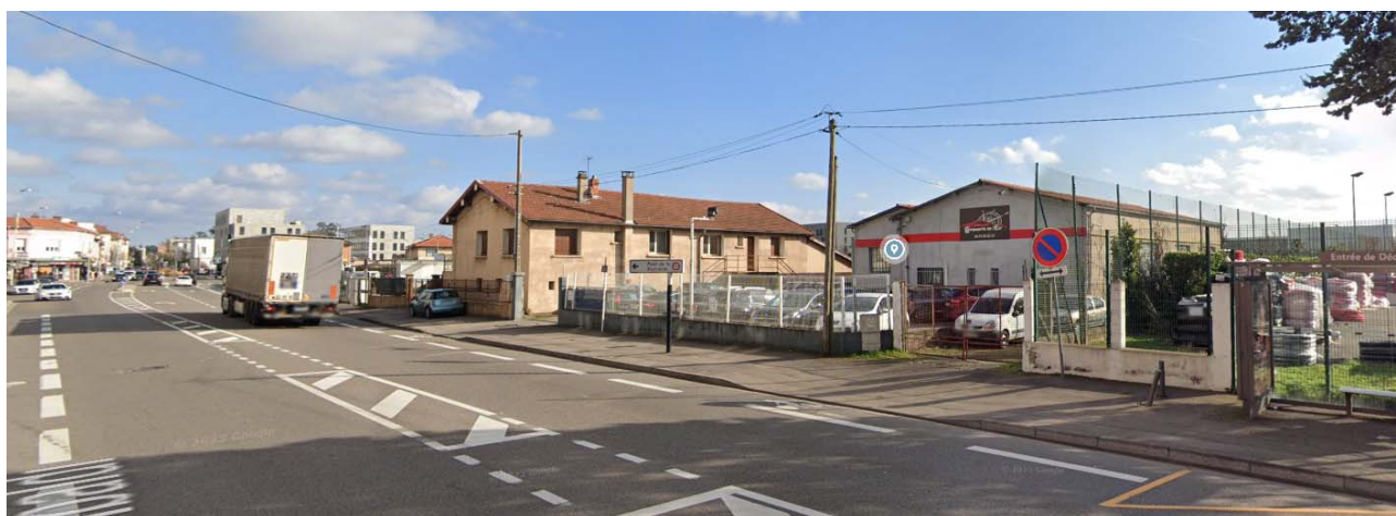
Figure 42 : Vue Ouest depuis l'avenue Garibaldi
