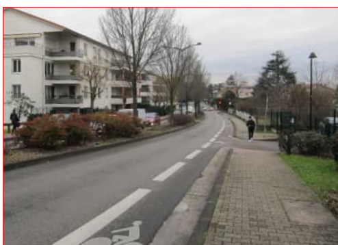
Voie cyclable aménagée rue Jules Ferry - @Agence d'Urbanisme
