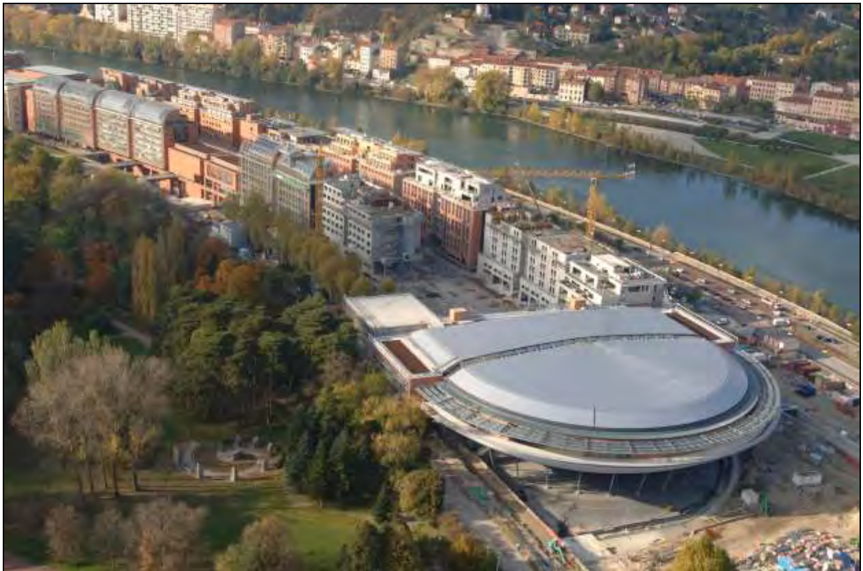
Travaux d'extension du palais des congrès et de la salle 3000, 2005 (2898 WM 011)
