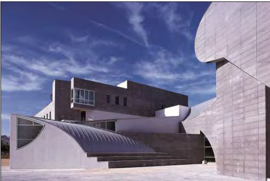
...et après réalisation (5698 WM 010)
