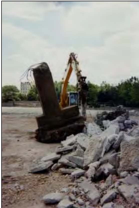
Travaux de terrassement, 1998 (2294 WM 036)
