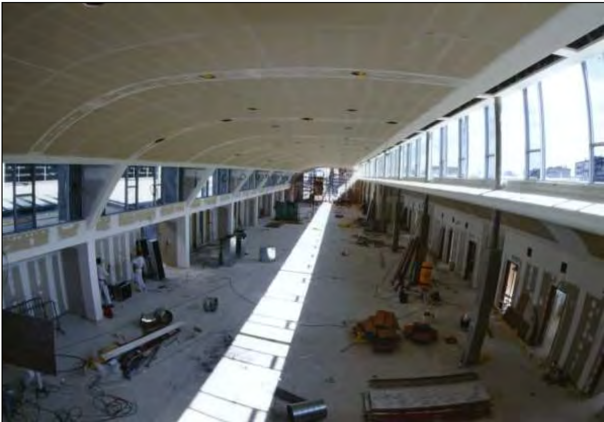
En travaux... (5967 WM 037-5)
