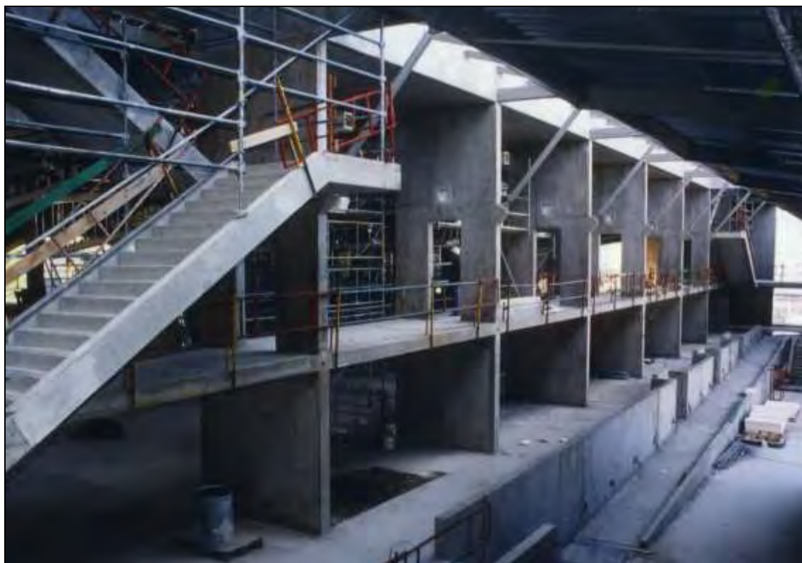
En travaux... (5967 WM 032-4)
