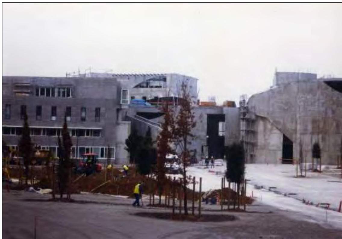
En travaux... (5967 WM 031-20)
