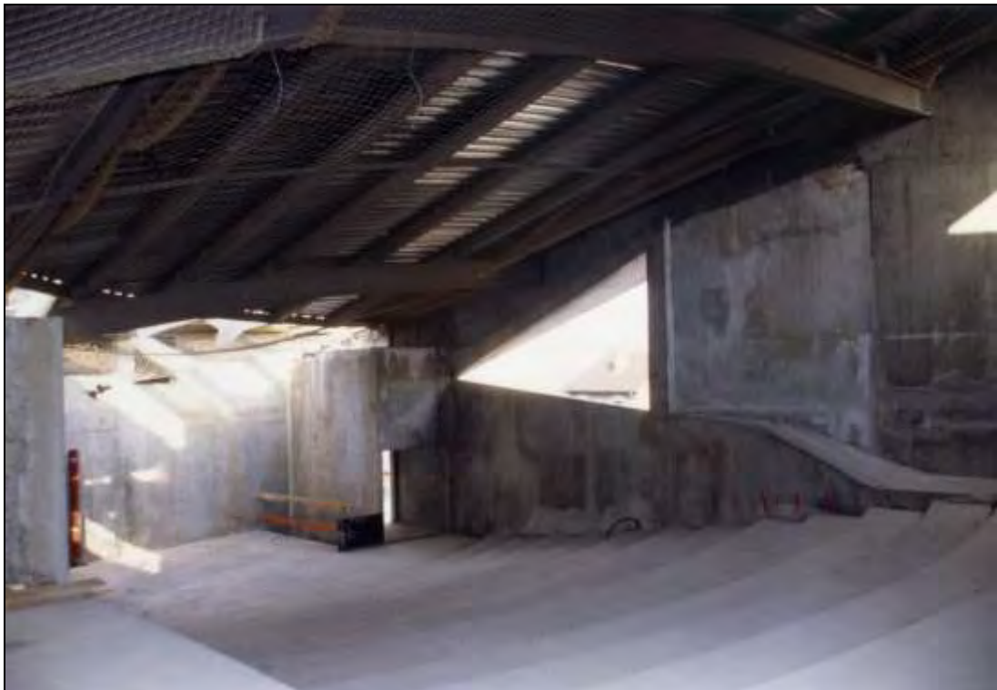
L'amphithéâtre en construction, 1999 (5967 WM 031-32)
