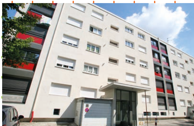
2014 Première réhabilitation énergétique avec celle de la résidence de la Boube.
