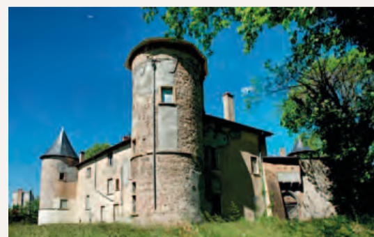
▶▶▶ Le Château de La Motte avant sa rénovation.
