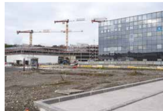
→ La future esplanade, dont les travaux ont démarré, permettra de relier l'hôpital, le pôle multimodal, le quartier cœur de Vallon et le nouveau parc urbain.
