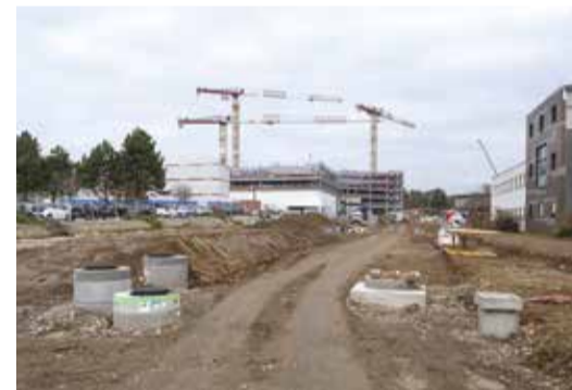
→ Sur le chemin du Grand Revoyet, les travaux de la gare bus démarrent, à la suite de la démolition du pont.
