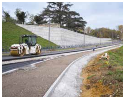
→ Fin novembre, pose des enrobés sur l'avenue Impératrice Eugénie.
