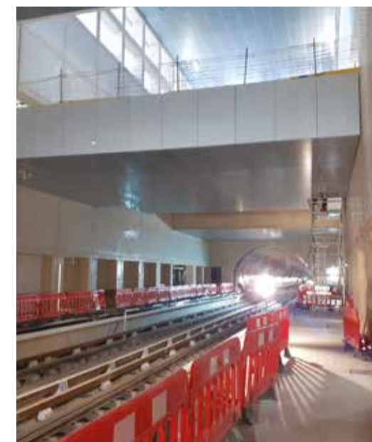
→ Les travaux d'aménagement se poursuivent activement au sein de la station de métro Saint-Genis-Laval Hôpital Lyon Sud.
