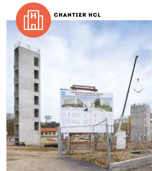
→ Les travaux du parking silo destiné aux salariés de l'Hôpital Lyon Sud avancent également avec les premières structures déjà bien visibles (escalier de secours, cage d'ascenseur).
