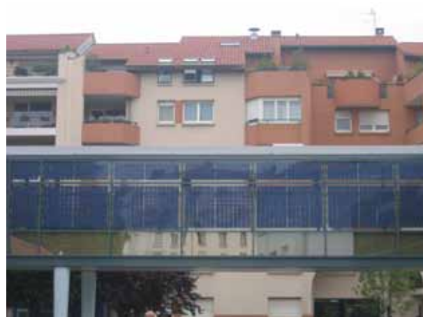
Vitrages photovoltaïques sur l'école Nové Jossierand – Lyon 3 ème Source ALE Lyon
