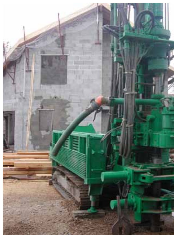
Forage chez un particulier de Corbas pour installer une pompe à chaleur sur eau de nappe.
