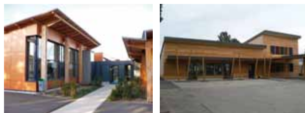
École primaire de la Tour-de-Salvagny / École Parsonge à Dardilly Source ALE Lyon
