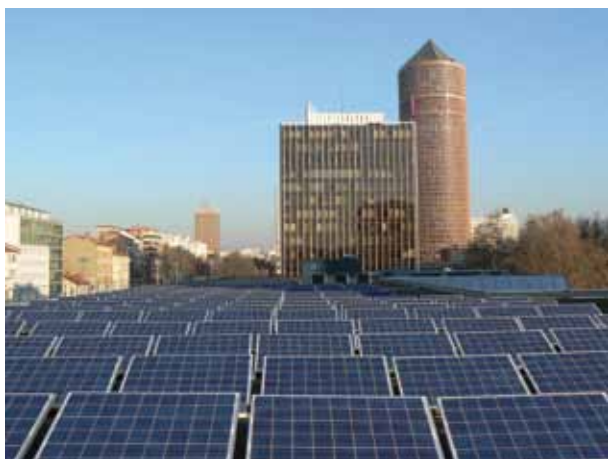
Centrale photovoltaïque de l'Hôtel de la Communauté urbaine de Lyon – Lyon 3 ème - Source ALE Lyon
