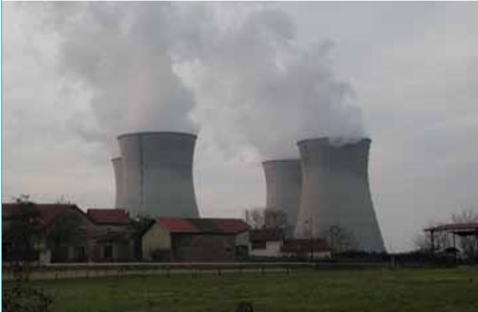
Tours de refroidissement de la centrale nucléaire du Bugey (01)
