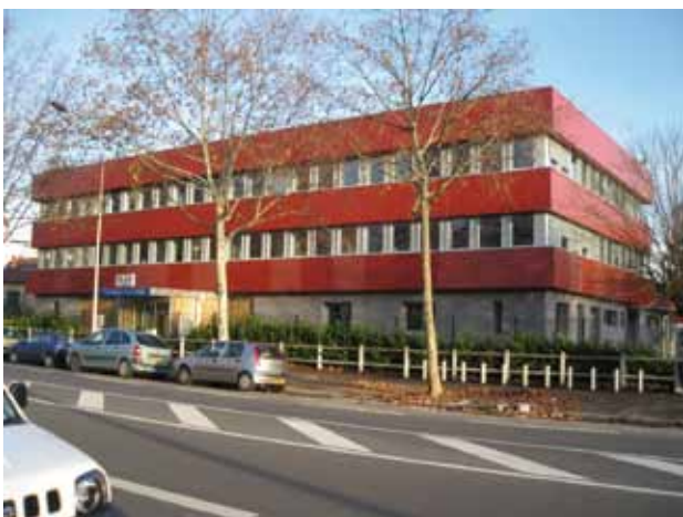
Maîtrise de l'énergie pour la réhabilitation des locaux de l'ALLP à Lyon 8 e . Source ALE Lyon.
