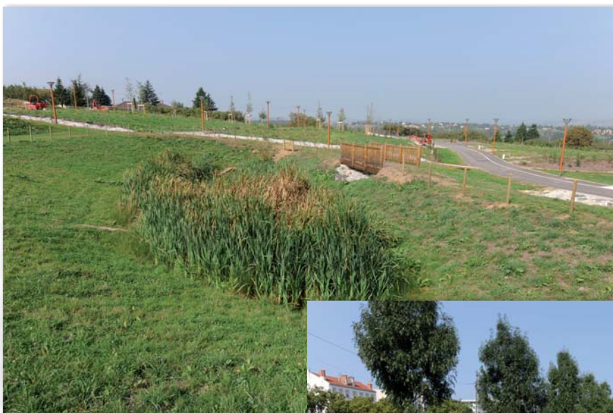
La Tour de Salvagny - ZAC du Comtal Bassin de rétention
