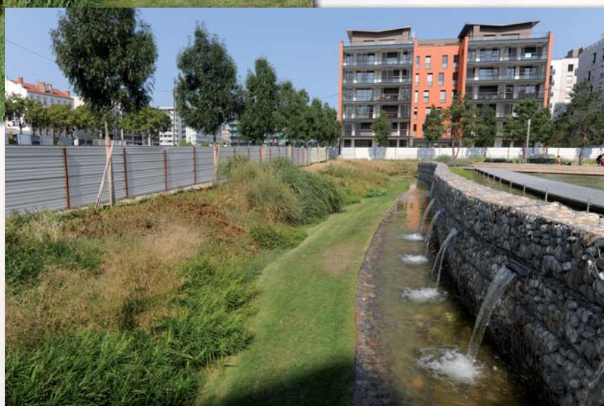
Lyon 3ème - Parc Jacob Kaplan Bassin d'infiltration
