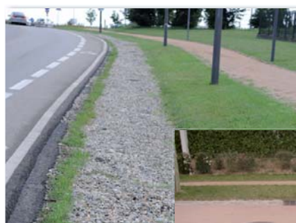
Saint-Priest - Rue de l'Aviation (tranchée)
