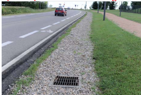
Saint Priest - Rue de l'Aviation (tranchées)
