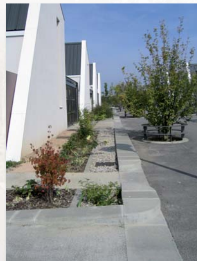
Saint-Priest - Les Hauts de Feuilly Tranchée infiltrante
