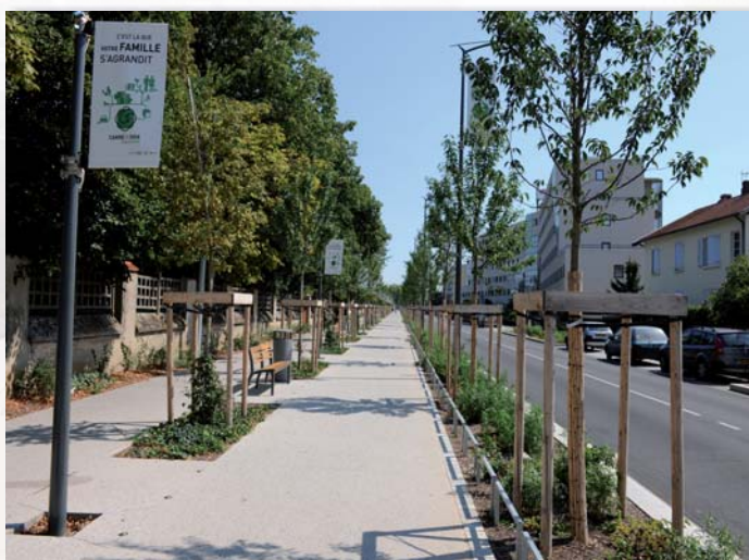
Vaulx-en-Velin - Carré de Soie Structure réservoir sous trottoir alimentant les bandes plantées
