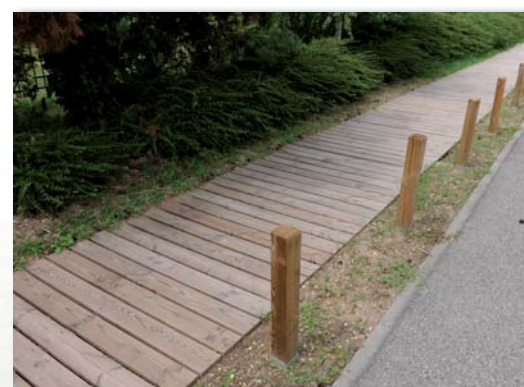
Saint-Priest - Parc Technologique Tranchée recouverte de platelage bois
