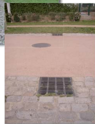
Puits sur voie piétonne
