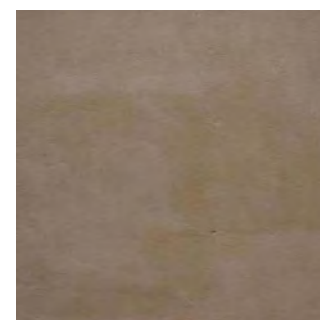
Enduit lissé à la truelle
