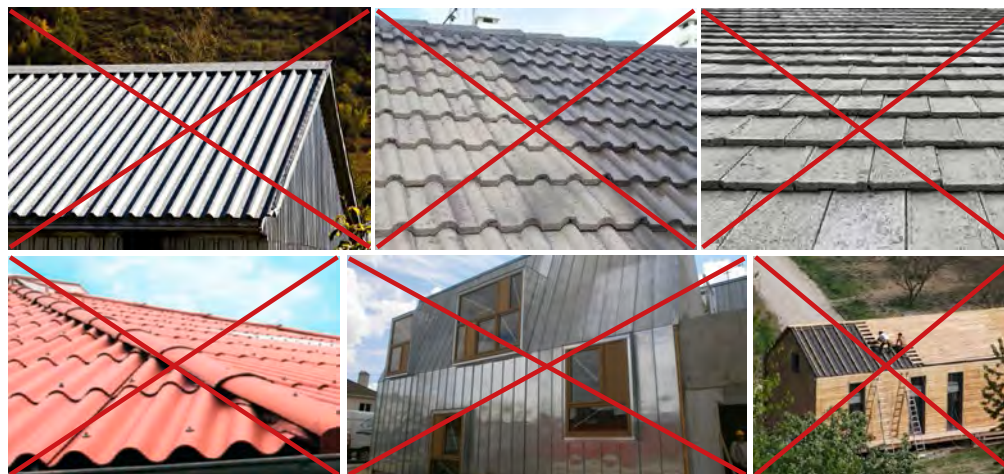
Revêtements interdits : tôles, bacs aciers, tuiles bétons, revêtements réfléchissants, bardages, fibrociment non recouvert de tuiles...
