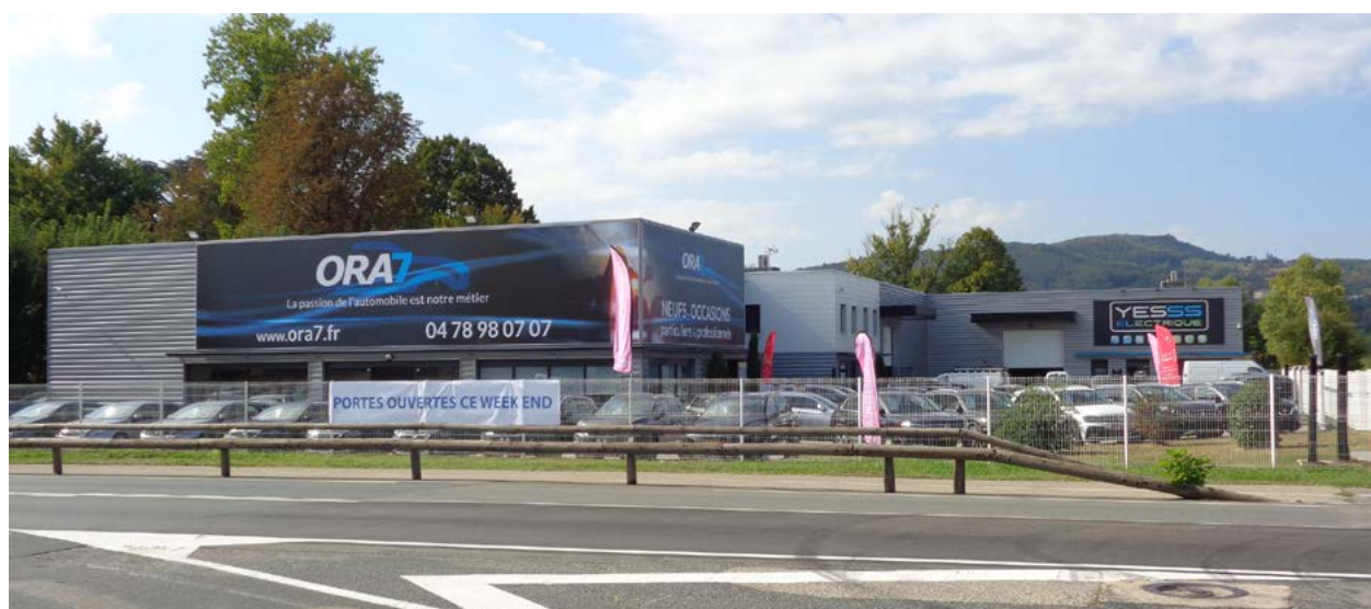
Enseigne murale de grande taille et nombreux dispositifs posés au sol de moins de 1m 2
