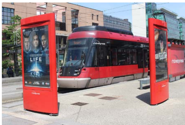
Exemple de station de tramway sur laquelle sont installés deux mobiliers urbains de petite taille
