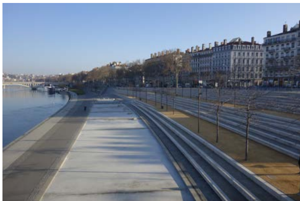
Quais du Rhône
