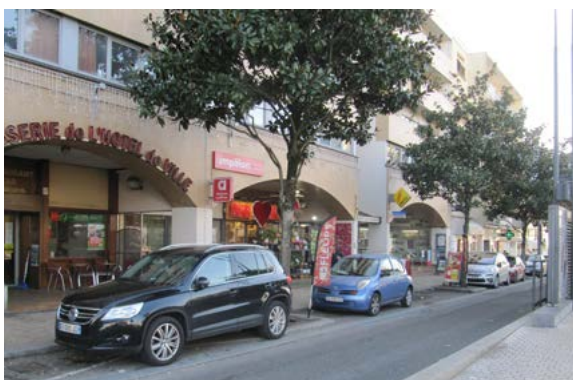
Exemple d'enseignes s'intégrant peu à la façade et disposées de manière hétérogène
