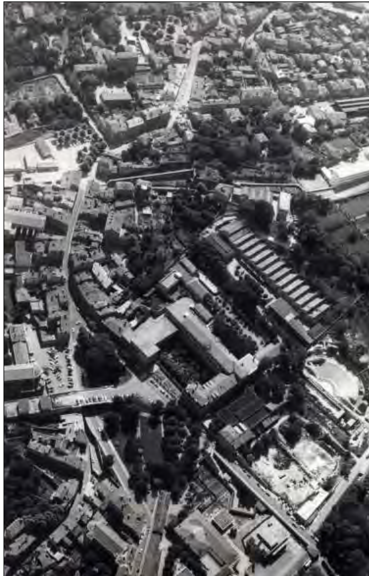
3272 WM 437 Quartier Champvert, nouveaux immeubles d'habitation. Photographie
