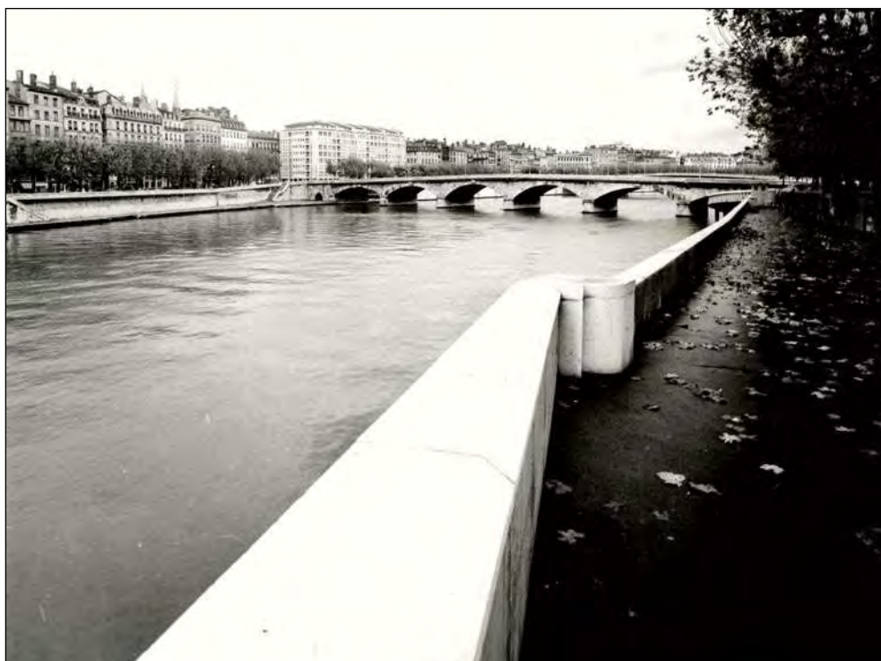
3272 WM 257 Pont du Change, la culée de la rive gauche vue d'amont. Photographie
