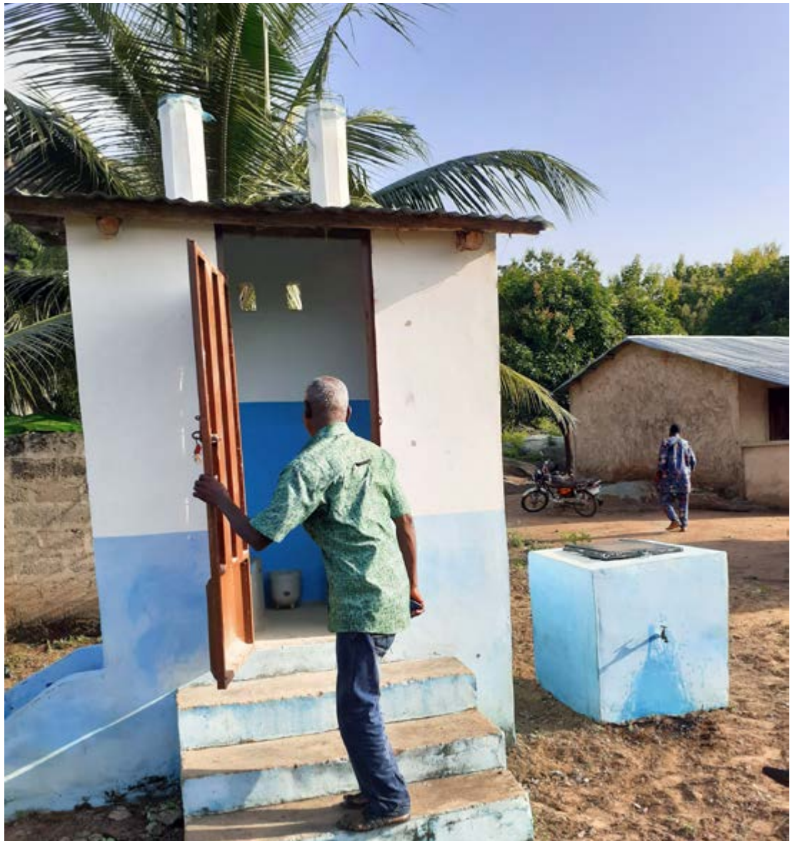
Latrine familiale au Togo.
