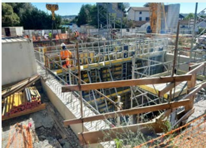
Vue de la future station d'épuration.
